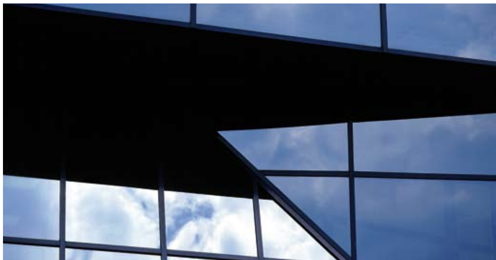
Selbstreinigendes Glas in Kombination mit Sonnenschutz schützt Innenräume im Sommer vor solaren Zugewinnen und im Winter vor Wärmeverlusten
