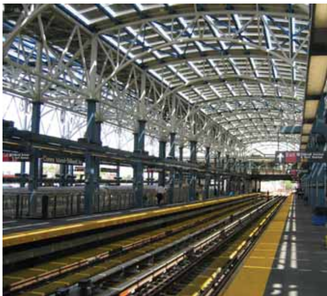
Das Dach der Metro-Endstation „Stillwell-Avenue“ in New York besteht größtenteils aus Dünnschicht-Solarstrommodulen.
